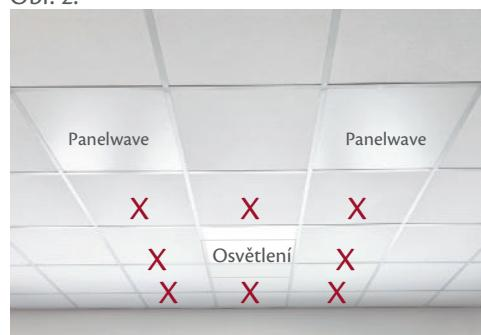
**X Bezpečnostní vzdálenosti:** Používají se u stropu se západkovým vkládáním jak osvětlení, tak i topné články, pak doporučujeme dodržet odstup jedné řady.
