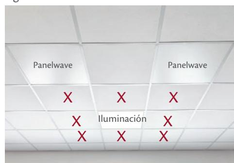
**X Distancias de seguridad:** Si en un techo reticulado se utilizan tanto luces como elementos calentadores, se recomienda mantener una distancia de una fila.
