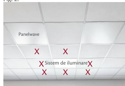
**X Distanțe de siguranță:** Dacă în cazul tavanului casetat, sunt montate atât sisteme de iluminare, cât și elemente de încălzire, se recomandă menținerea unei distanțe de un rând.
