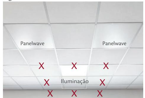
**X Distâncias de segurança:** Caso no teto de encaixe sejam utilizadas/os iluminações bem como elementos de aquecimento, recomenda-se que se mantenha uma distância de uma fila.
